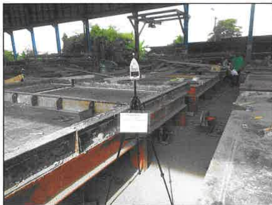
โรงงานผลิต Plank คลังสินค้า บริเวณกลาง Line ผลิต Zone 3
