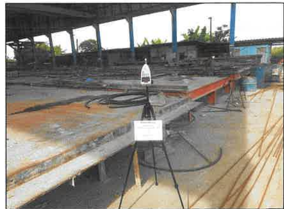
โรงงานผลิต Plank คลังสินค้า บริเวณท้าย Line ผลิต Zone 3
