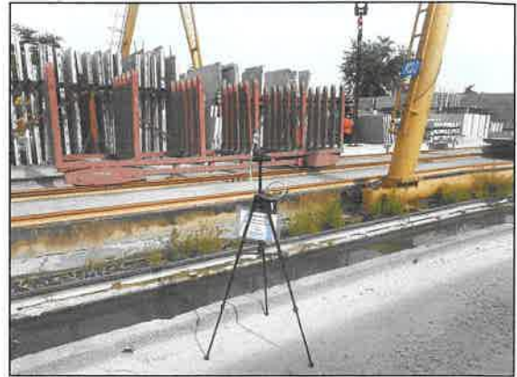
โรงงานผลิต Plank คลังสินค้า บริเวณกลาง Line ผลิต PC 2 ตรวจวัด Total Dust
